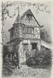
Pavillon J. W. Huesgen, Traben
